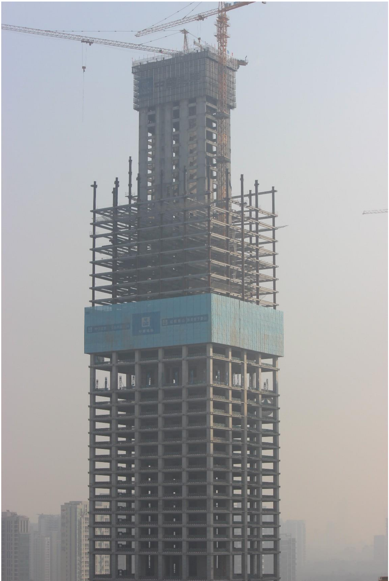
“航天科技廣場”項目完成主樓核心筒施工封頂
